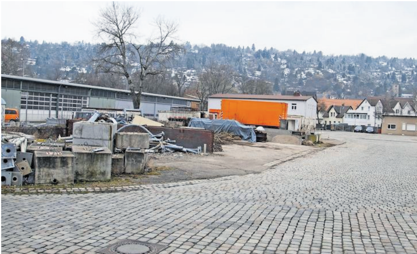
Im Innenbereich des AWS-Betriebshofs Gingener Straße soll eine moderne Abstellhalle für Müllfahrzeuge entstehen. Fotos: Kuhn
